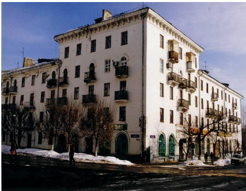
Саранск, ул. Советская, 34. Современный вид здания
