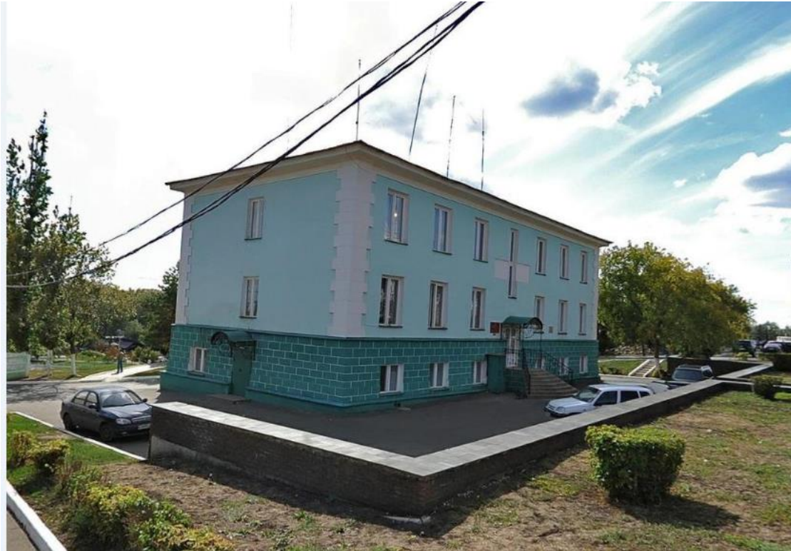
Саранск, ул. Советская, 34. Современный вид здания
